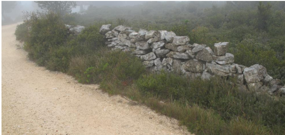
Fotografia 111 – Vista parcial do muro de pedra seca – Covão do Tojal.
